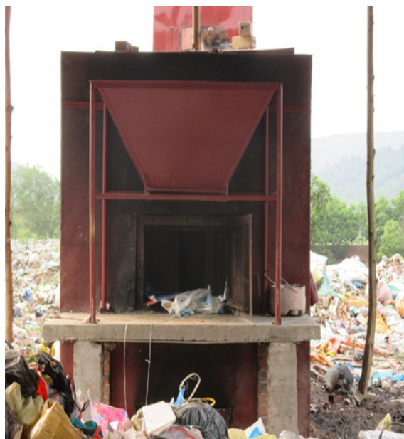
Hình 2. Hình ảnh lò đốt tại bãi rác Hồ Mơ.
