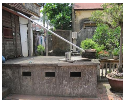
b) Bể nước mưa
