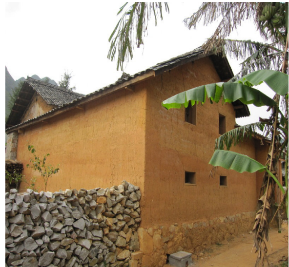
(d) Nhà trình tường sau khi đã sửa chữa xong (Ảnh Đặng Văn Luyến., 2013).
