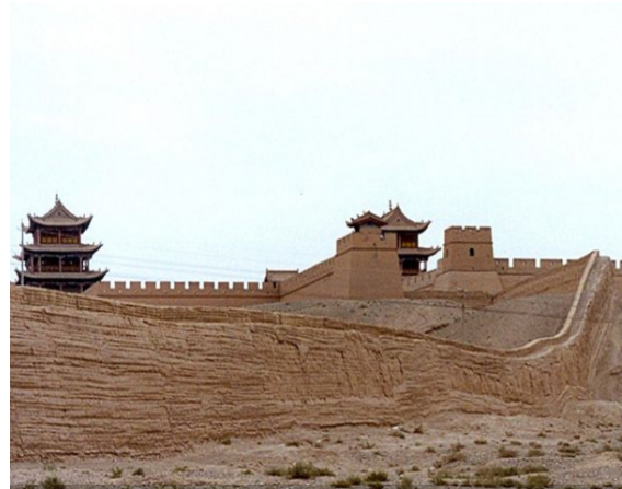
b) Mặt cắt Taipa, Vạn Lý Trường Thành, Trung Quốc, xây dựng từ thế kỷ thứ 5 trước Công nguyên [2]
