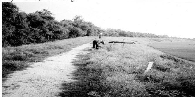
Hình 10. Hình ảnh khảo sát thẳm tại kè Mỹ Trung.
